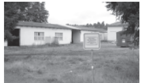
Das marode ehemalige GFK-Gelände an der Berggartenstraße.
