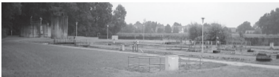
Die Kläranlage in Lavelstlo
