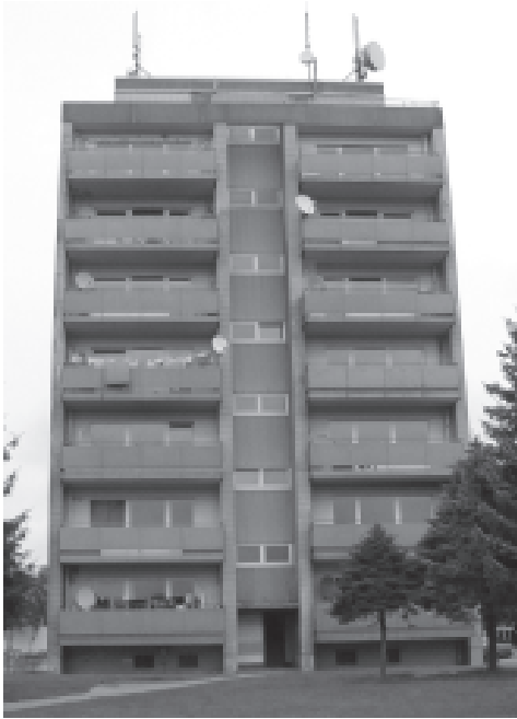
Das Hochhaus in Uchte wird geschleift.
