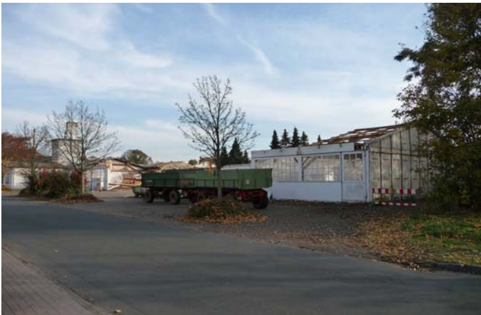
Die Gebäude der ehemaligen Tischlerei Gehlker werden abgerissen
