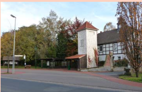
Der alte Transformator an der Bushaltestelle soll abgerissen werden
