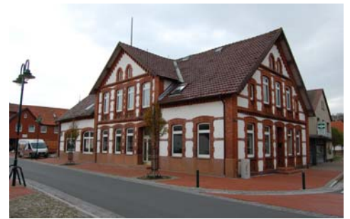
Die ehemalige Gaststätte Hofmeister wird zu einer Arztpraxis umgebaut
