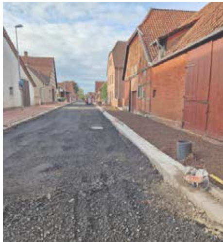
Sobald die Witterungsverhältnisse es zulassen, wird weiter gebaut
