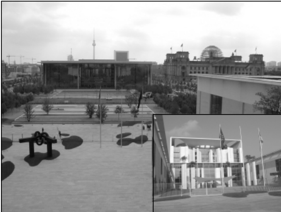
Ein Blick vom Balkon des Kanzleramtes. Man schaut direkt auf das Abgeordnetenhaus und das daneben stehende Reichstagsgebäude. Auf dem kleinen Foto ist der Balkon des Kanzleramtes zu erkennen.
