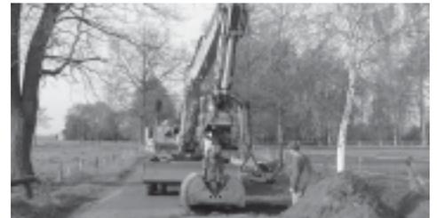
Die Firma Horstmann beim Freilegen und Austauschen der Rohre an der Kreuzung.
